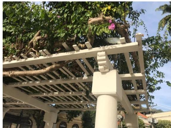
Figura 16: Madeiramento danificado.
