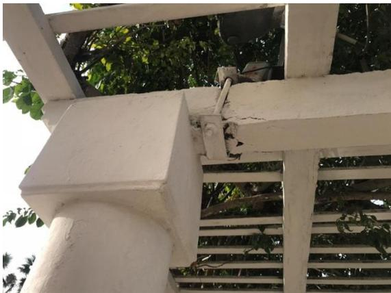
Figura 15: Fratura no concreto.
