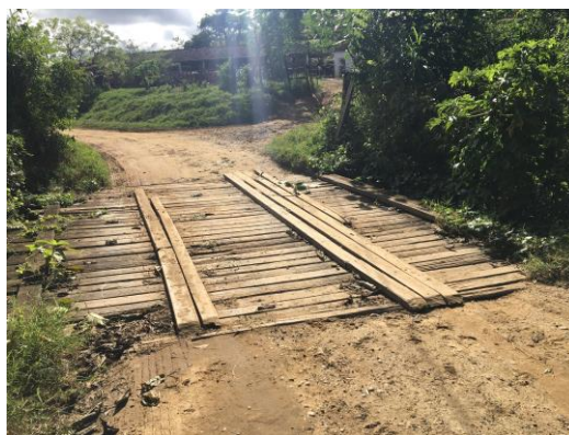
Ponte Capim D'Angola
