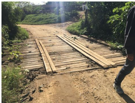
Ponte Capim D'Angola
